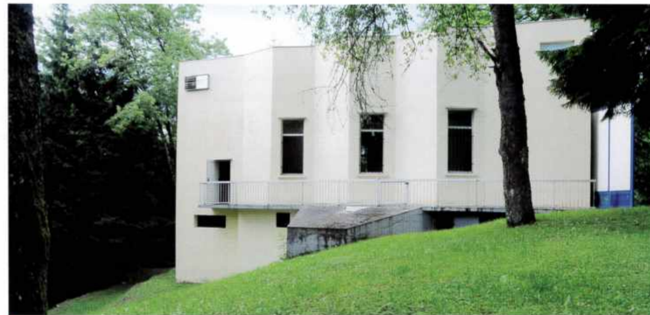
▲ La centrale de La Balme (Savoie) a des murs en accordéon pour limiter l'effet ping-pong entre deux parois. L'efficacité est augmentée par la pose d'isolants phoniques. Photo : Cayrol International
