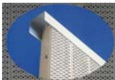
Lisse haute asymétrique permettant le guidage supérieur des panneaux
